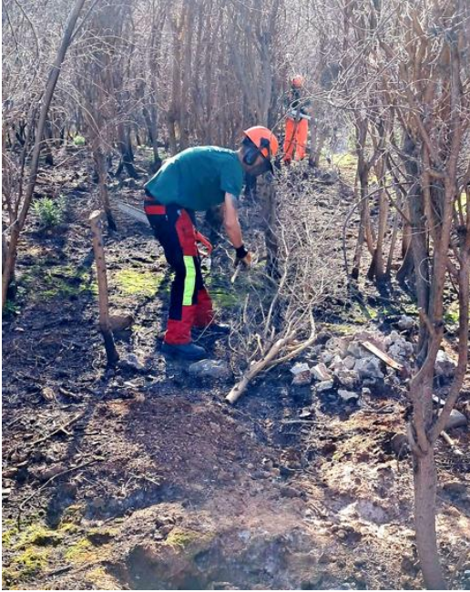
Arbeiten am Mirador Bermejo
